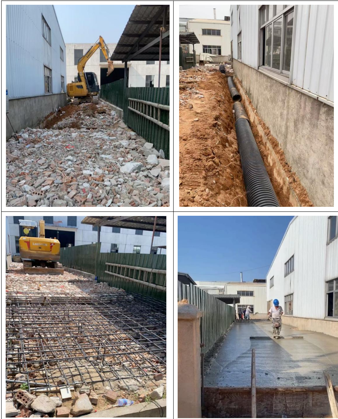
图 3.4-1 基础设施施工过程现场照片
